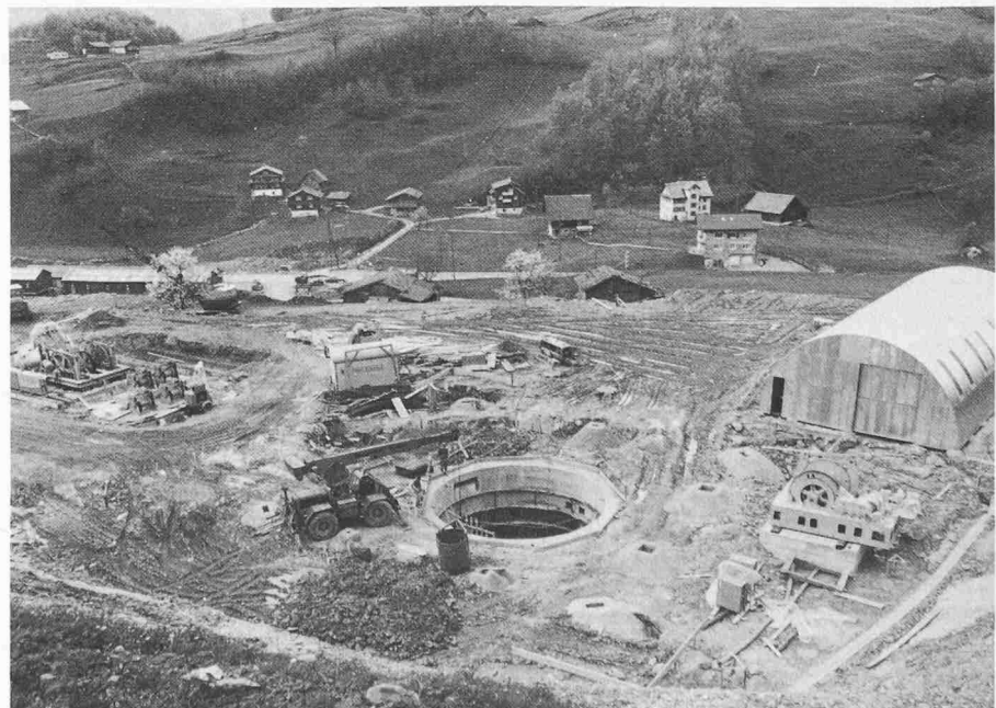
Bild 2. Arbeitsplattform für die Schachtinstallationen. In Bildmitte Grundring und Startschacht, links Schachtwinde teilmontiert mit Hilfswinden, rechts Werkstatt und Bühnenwinde
