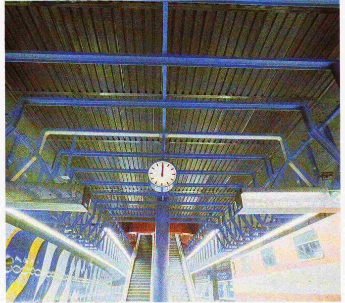
Bild 4. Rippenkonstruktion über dem Perrongeschoss
