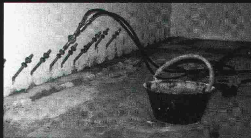
Elastische Abdichtungs-Injektion-Rascoflex in einer Zivilschutzanlage.
