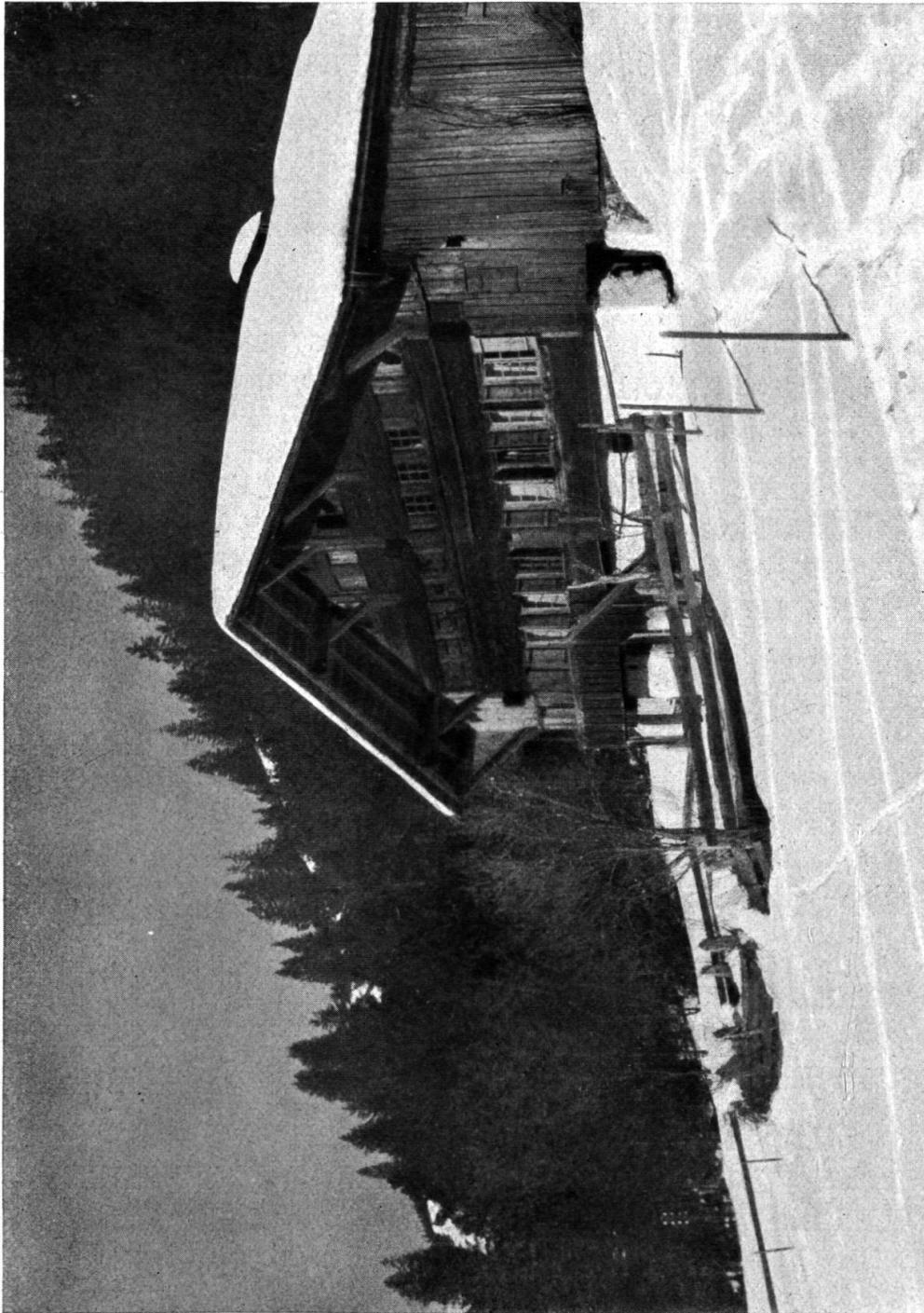
Les principes essentiels qui ont présidé à l'établissement de sa charpente, l'assemblage des supports de son avant-toit, ses pièces énormes équarries à la hache, dont l'une va d'un bout à l'autre de la façade, font de cette maison le type le plus parfait des constructions en bois, dans le Pays-d'Enhaut, au XVI<sup>e</sup> siècle.
