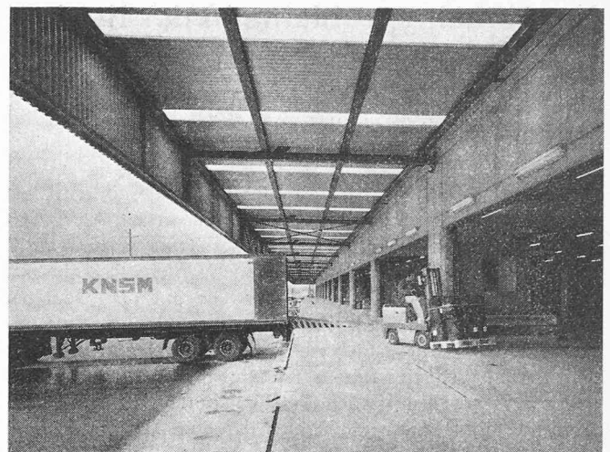
Gedekte Nordrampe mit Anpassrampen für den Camionverlad
