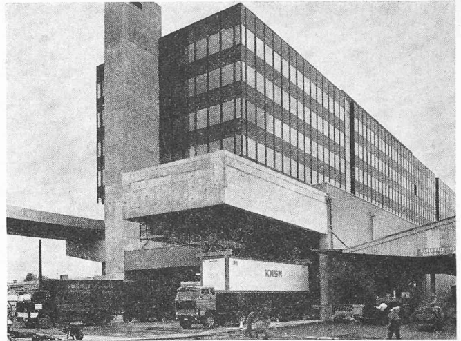
Ansicht Süd-West. Auskragung der Kranbahn für den Transcontainerumschlag
