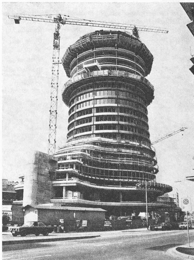
Bild 1. Neubau der Bank für Internationalen Zahlungsausgleich
