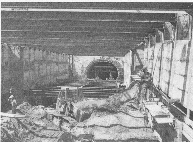
Bild 6. Los 5: Spriessung und Aushub
