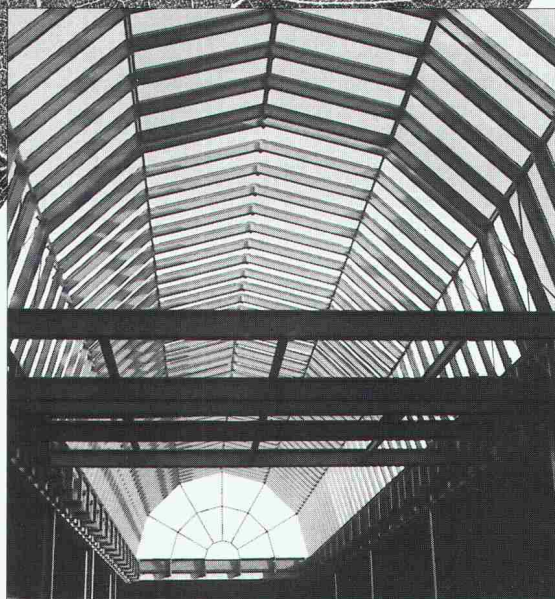
Stahl- und Industriebau
