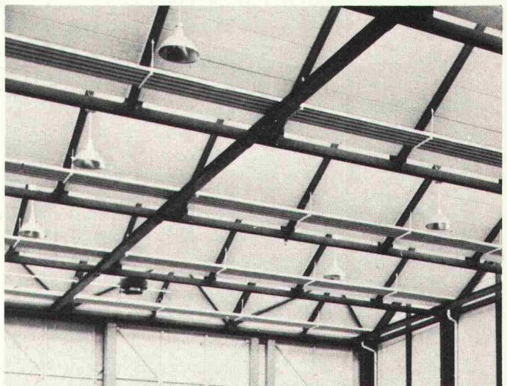
DURISOL-Dachelemente bestehen aus einem hochisolierenden Körper, der oben durch eine abtafelierte Feinbetonschicht geschützt wird. Daraus resultiert die hervorragende thermische Isolationsfähigkeit. Der Erfolg der DURISOL-Dachelemente beruht
