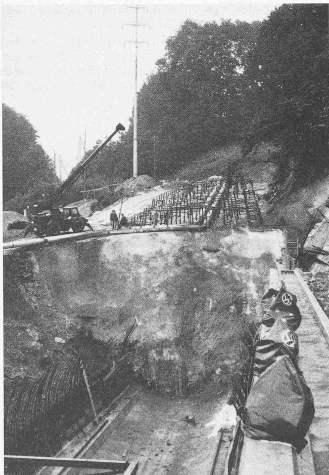
Bild 12. «Startgrube» der Tunnelausbrucharbeiten im Bereich der Tagbaustrecke mit Gefrierplanum im Hintergrund
