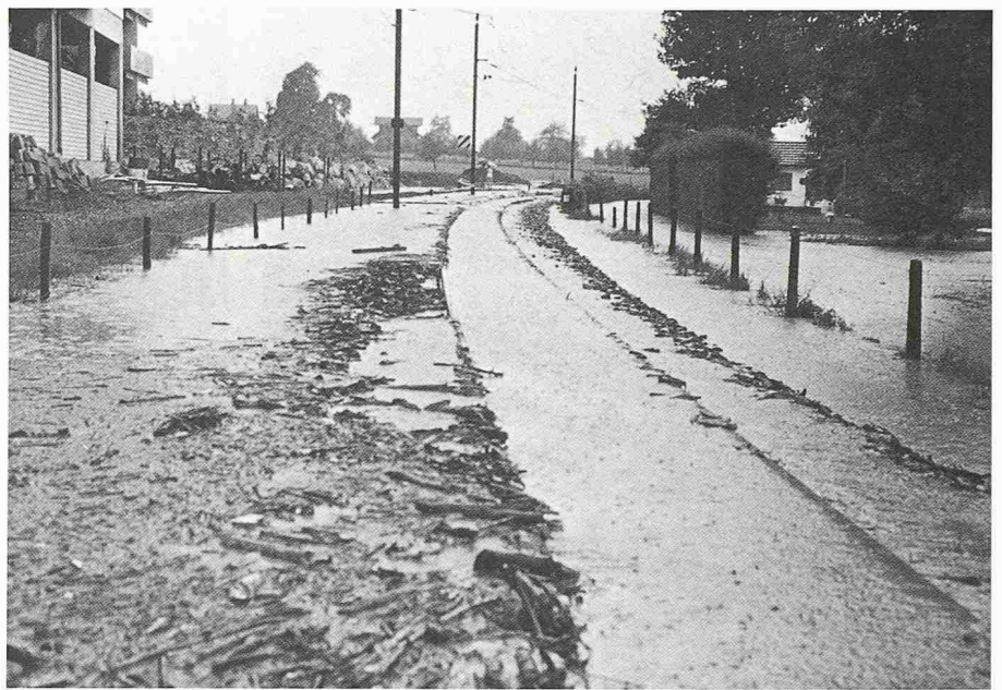
Bild 3. Das überschwemmte Trasse der Brünigbahn nach dem schweren Unwetter von 1984 in Sachseln
