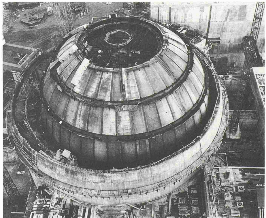
Bild 4. Bau des Containments für das KKW Gösgen, Stand Januar 1976
