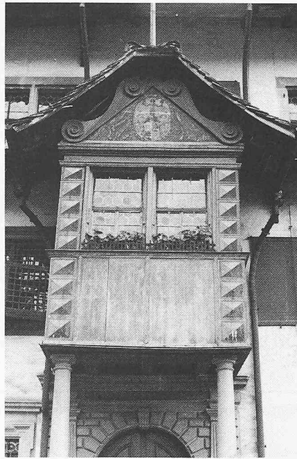
Erker aus Holz über dem Hauptportal, um 1663 angefügt, toskanische Säulen, Giebelmalerei mit Reding-Wappen
