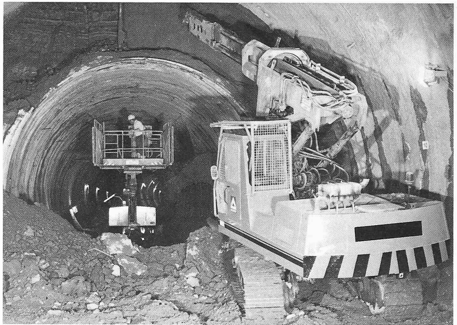
Bild 3. Während der Vortriebsarbeiten und der Sicherung mit Spritzbeton nach der NATM
