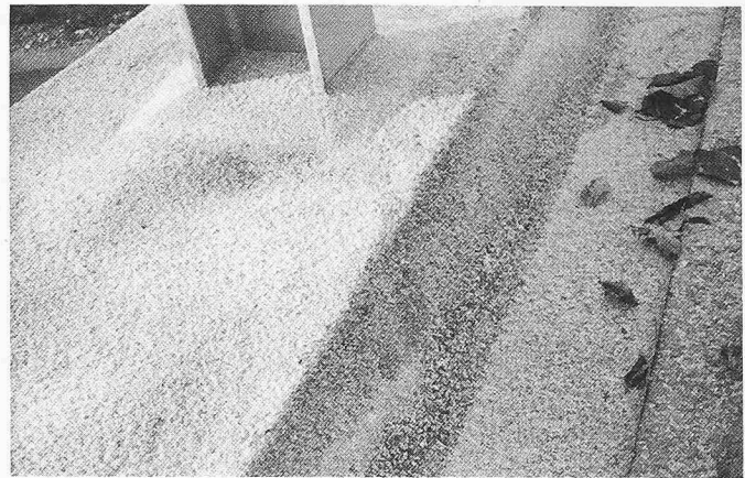
Bild 24. B-731. Fertig sanierter Konsolkopf mit Beschichtung
