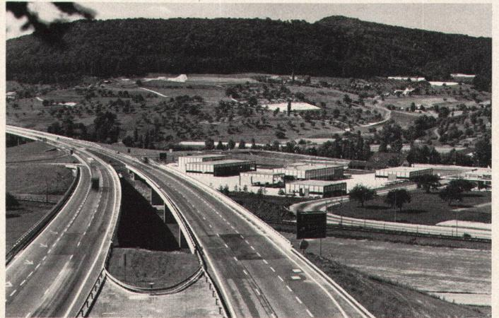
Der Werkhof der Nationalstraße N2 befindet sich am Anschlußwerk Sissach und dient der Überwachung und dem Unterhalt des Teilstücks Belchentunnel–Hagnau. Auf dem dreieckigen Areal von rund 25 000 m<sup>2</sup> sind, nach einem vom Amt für Straßen- und Flußbau empfohlenen Raumprogramm, sechs Hallenbauten mit differenzierter Nutzung errichtet worden. Als einheitliche Konstruktion wurde das USM-Stahlbausystem angewendet
