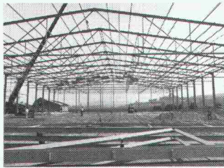
Rapidité d'exécution Halle de stockage Transports-Payerne SA. Halle de 4000 m 2 de surface, mise en exploitation 4 mois après signature du contrat.
