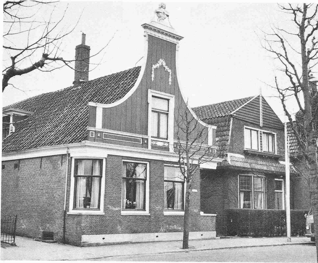
Hausfassade in Zaandijk (Holland). Glockengiebelhaus 17. Jh. Typ Glockengiebel. Ausdrucksmöglichkeit der Baumeister in der Formation der Fassade (Italienischer Einfluss)
