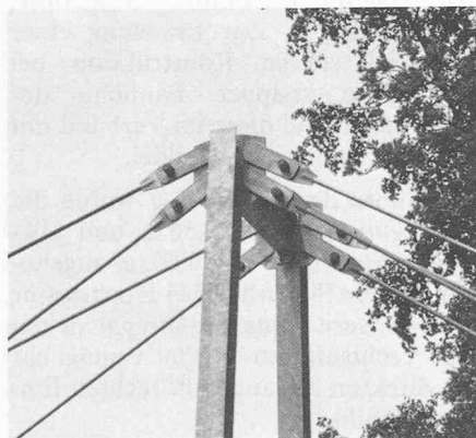
Bild 6. Pylonkopf mit Anschluss der Zugstangen
