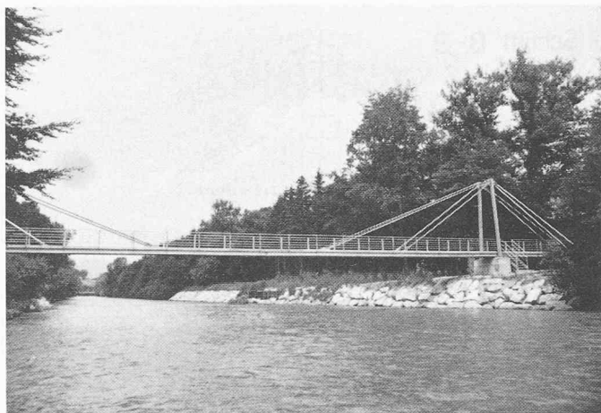
Bild 2. Ansicht des Steges von Oberwasserseite
