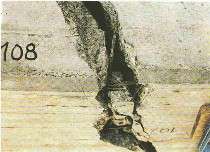
Bild 2. Sicherung Überbau Bildautor: A. von Glutz
