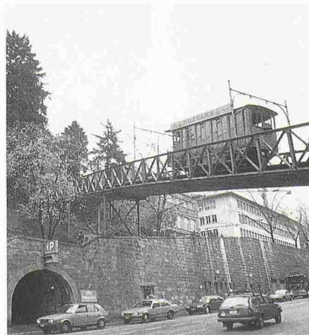
Täglich überqueren noch heute rund 540 Wagen der Polybahn die hundertjährige eiserne Brücke (Bild: W. Stadelmann)
