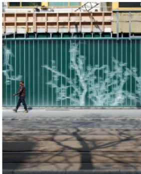
Profilglasfassade des Sockelgeschosses an der Badenerstrasse. Da die Montage der vorgehängten Fassadenelemente aus Glasfaserbeton im Obergeschoss noch nicht abgeschlossen ist, haben wir auf dem Titelfoto ein paar fehlende Platten eingefügt (Foto: af/Red.)
