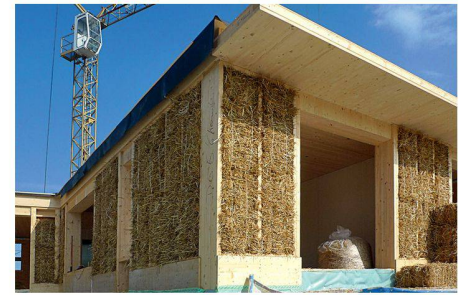
02 Holzständerbau mit eingebrachten Strohballen
