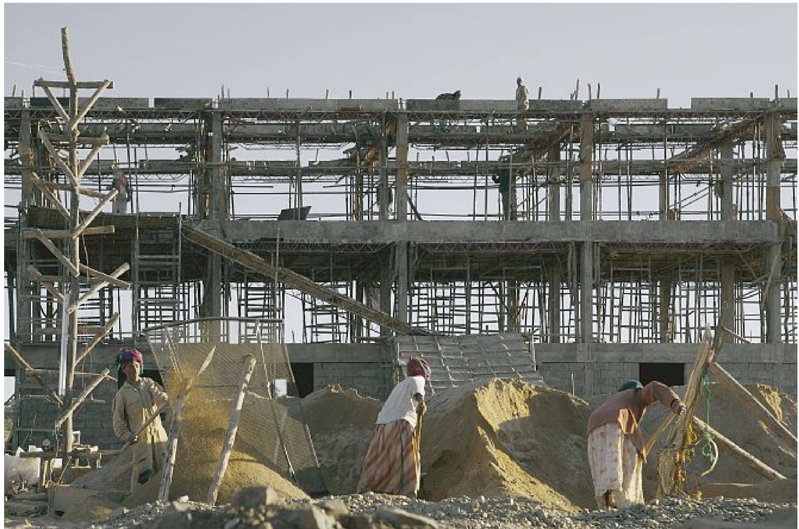
Bauarbeiten für den Campus in Axum
