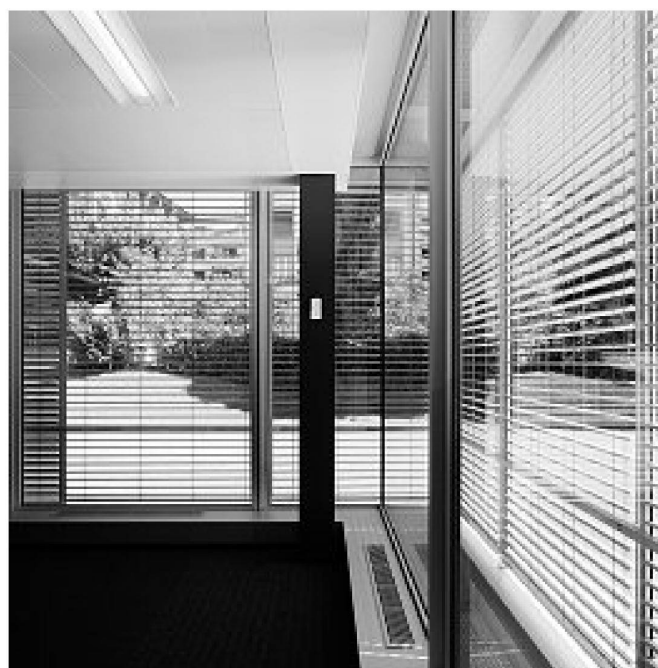
Intérieur du bureau avec façade double
