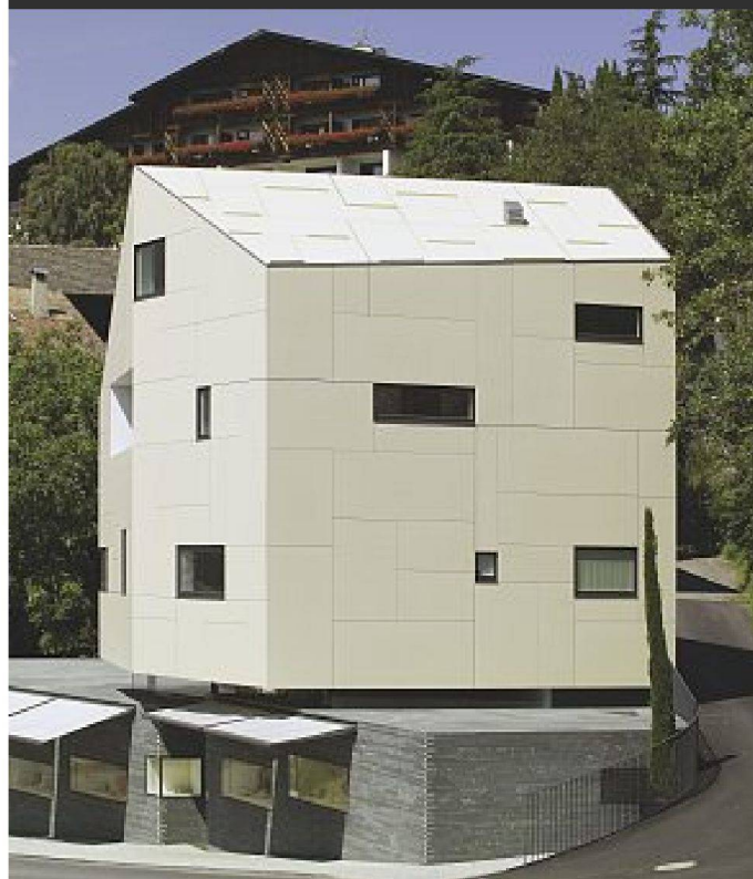
Architekten: Hölmler & Klotzner, I-39012 Meran Dach: INTEGRAL CREA Fassade: SWISSPEARL
