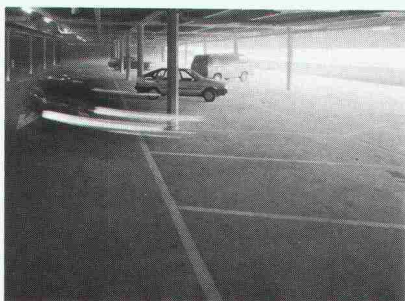
Parkdeck Glattzentrum, Wallisellen
