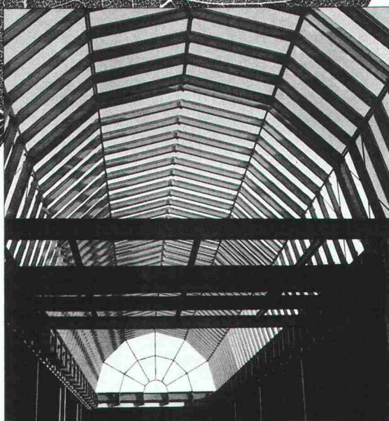
Stahl- und Industriebau
