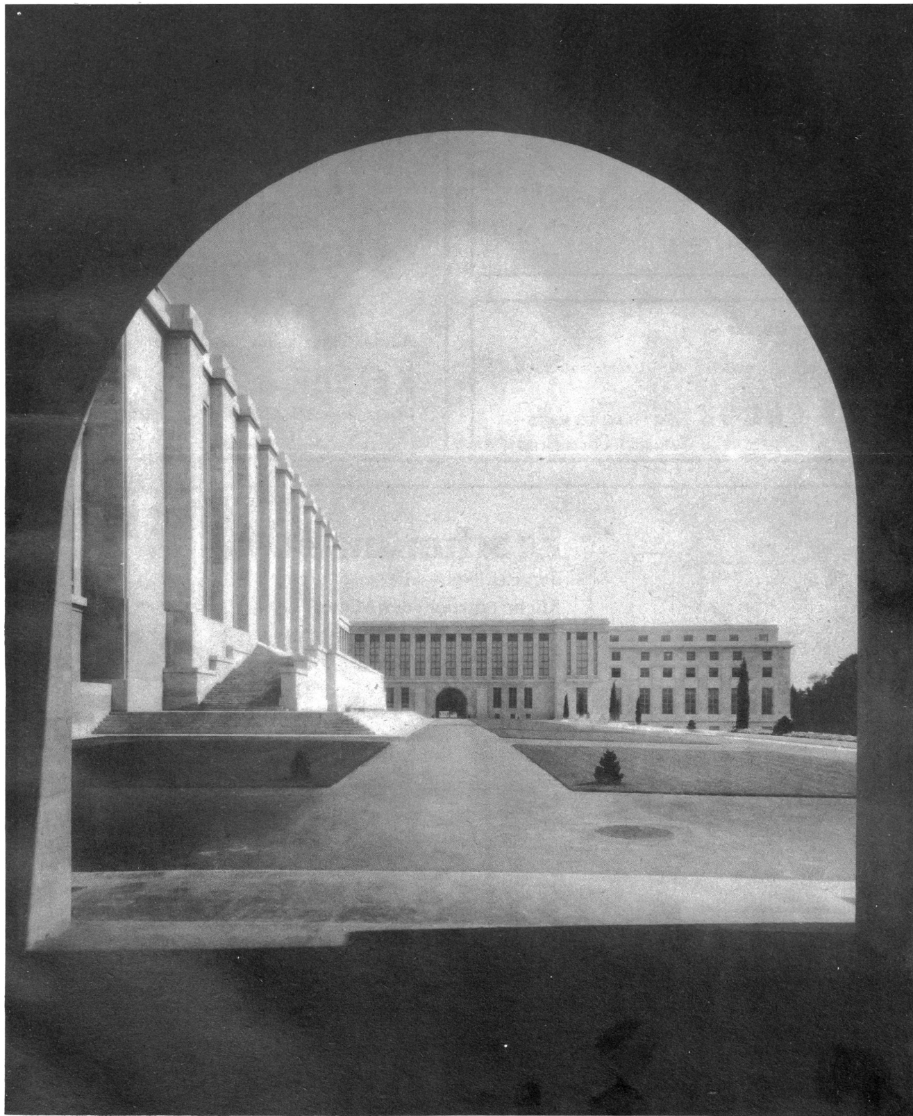
Der Völkerbundpalast in Genf. Blick durch das Westtor in den Hof. Phot W. Schweizer
