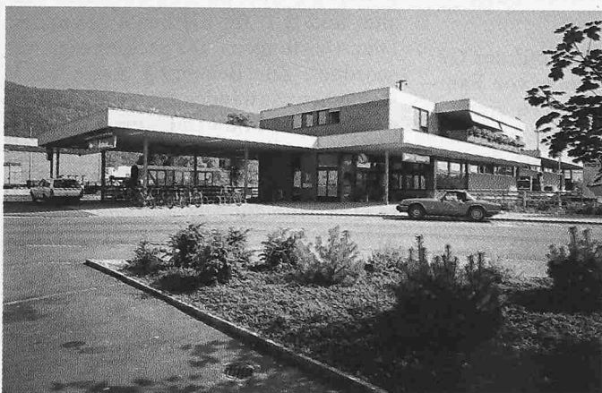
Bild 3. Rothrist: neues Aufnahmegebäude, mit konventionellen Bauteilen
