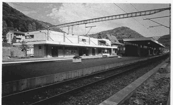
Bild 2. Tecknau: neues Aufnahmegebäude mit teilweise überdecktem Zwischenperron
