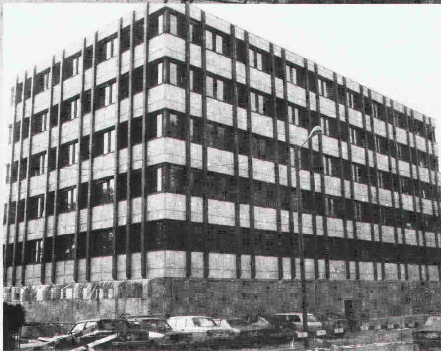
Verwaltungs- und Geschäftsgebäude der Publicitas AG, Lausanne. Dieses Bauvorhaben war bei der WAADT versichert.
