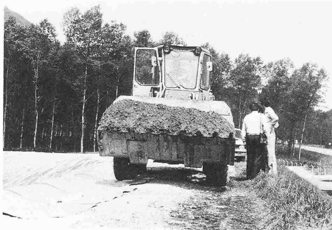
Bild 10. Demonstration der Durchschlagsfestigkeit der verwendeten KDB aus Sarnafil FP. Der beladene Trax fährt über die auf Kiesboden verlegten 2 mm starken KDB, ohne dass diese irgendwie beschädigt werden
