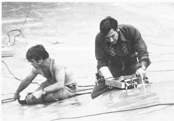
Bild 7. Verschweisssarbeiten zwischen zwei verlegten Bahnen mit dem Doppelheizkeilschweissapparat, mit dem zwei parallele Schweissnähte erzeugt werden. Der dazwischenliegende Hohlraum dient der Prüfung der verlegten KDB
