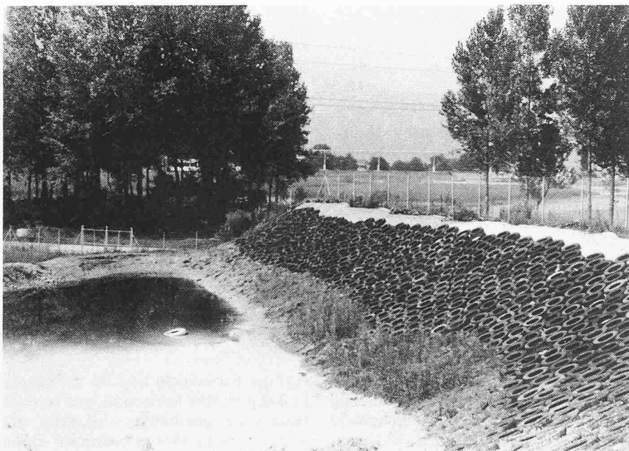
Bild 1. Blick auf die Pilotanlage auf dem Areal der Ciba-Geigy AG in Monthey. Die Böschungen wurden etwas zu steil ausgeführt. Um ihr Abrutschen zu verhindern, wurde die auf den Böschungen verlegte KDB aus Hochdruckpolyäthylen mit alten Autoreifen beschwert
