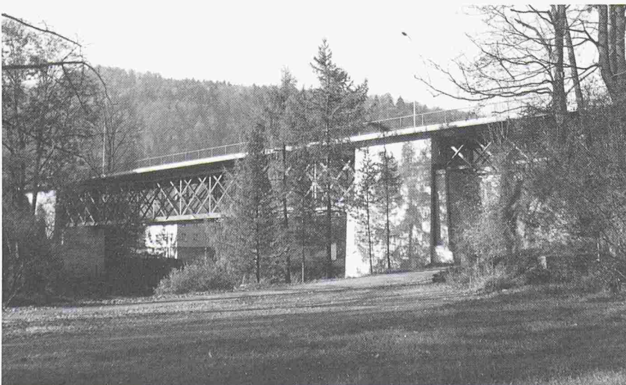
Thurbrücke bei Lichtensteig, erbaut 1870, umgebaut 1981
