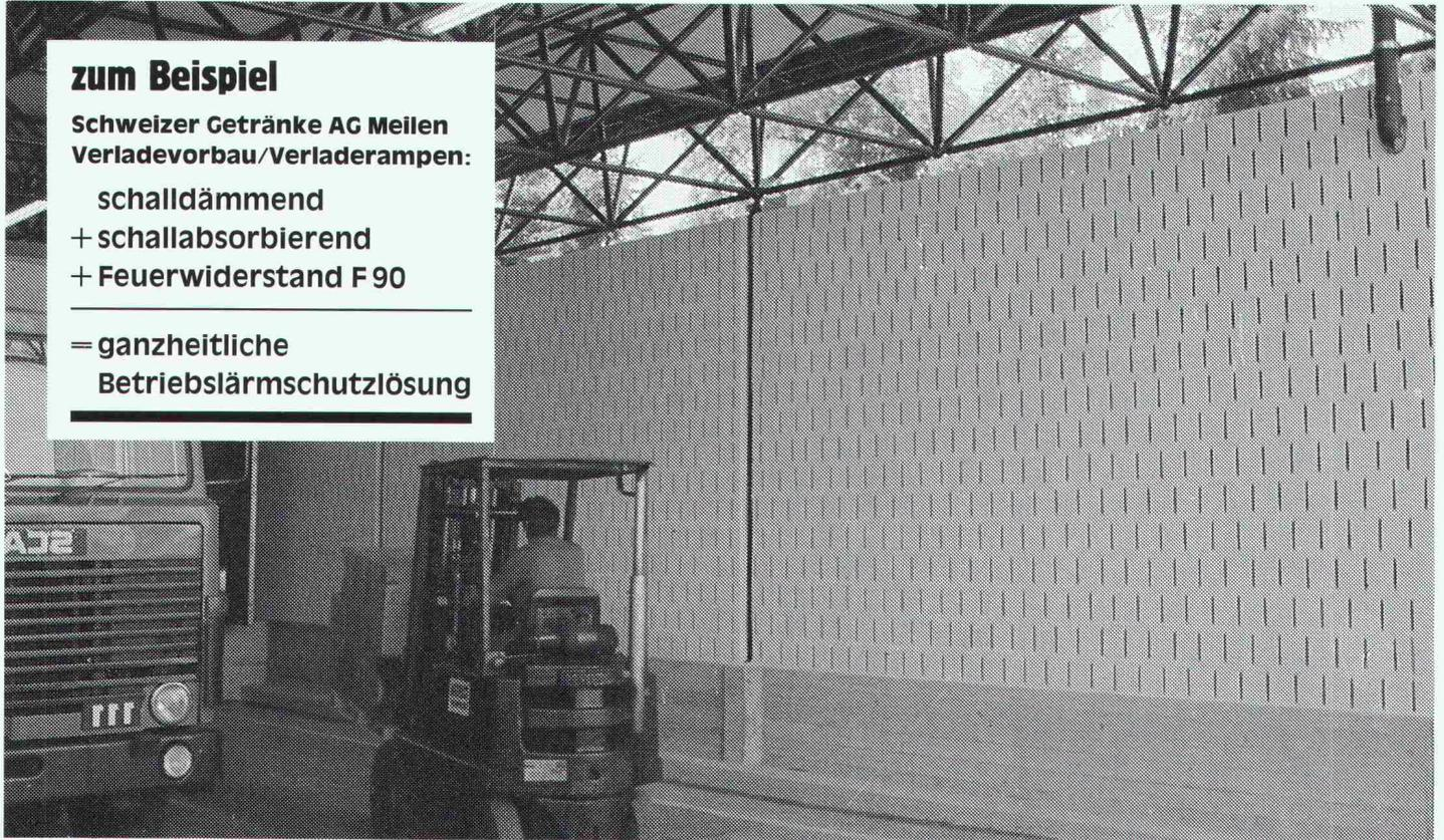
Der akustische Betonstein SOUNDBLOX bietet Architekten und Ingenieuren die ideale und kostengünstige Schallschutzlösung. Zum Beispiel für
