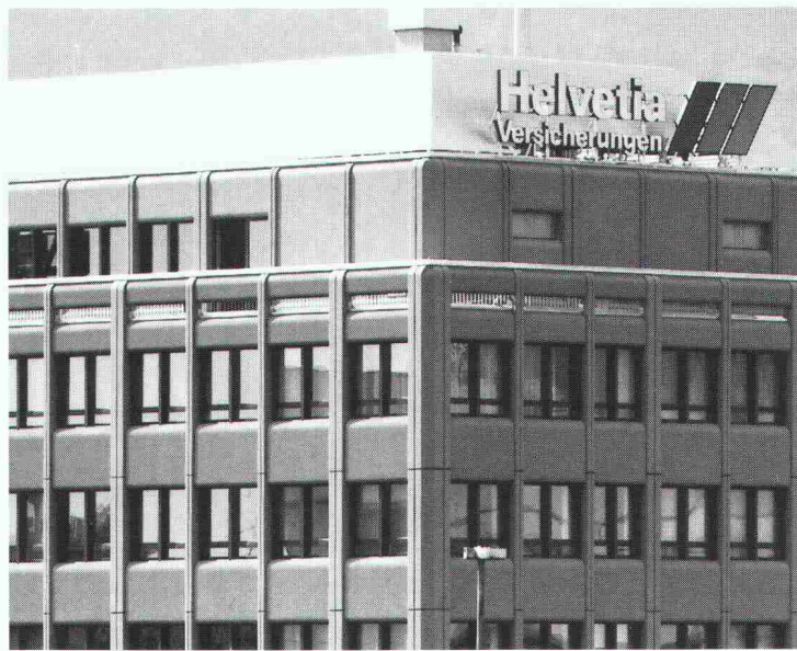
Geschäftshaus Helvetia-Unfall Zürich
