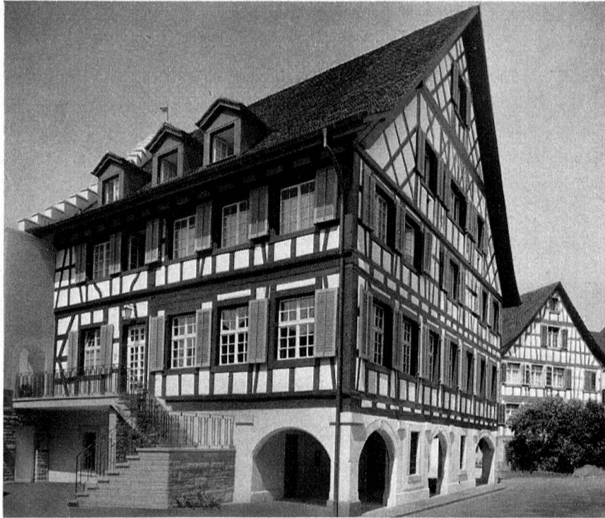
Ansicht des Rathauses von Bülach nach der Erneuerung
