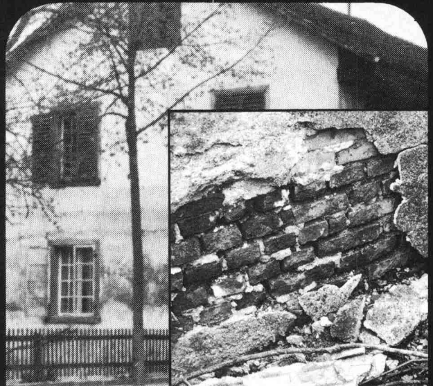
Renescan-Injektionen gegen aufsteigende Feuchtigkeit
