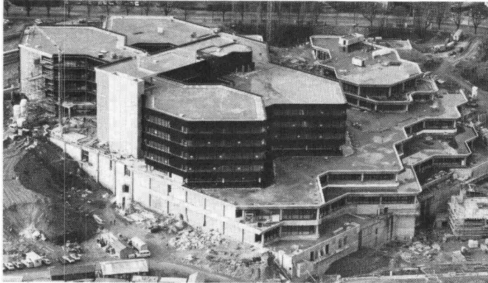
SKA-Neubau Uetlihof Zürich 28'000 m 2 Sarnafil
