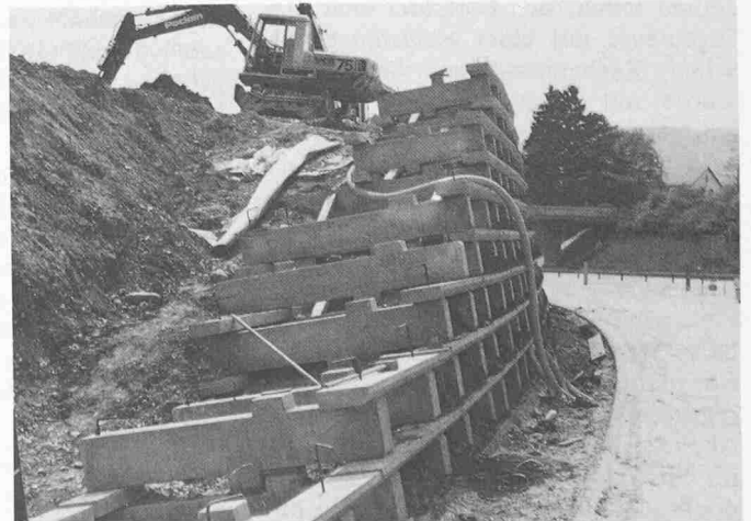
Bild 7. Wiederaufbau der Lärmschutzwand Wülflingen nach dem verbesserten System Favre-Murflex. Aufnahme Juni 1980
