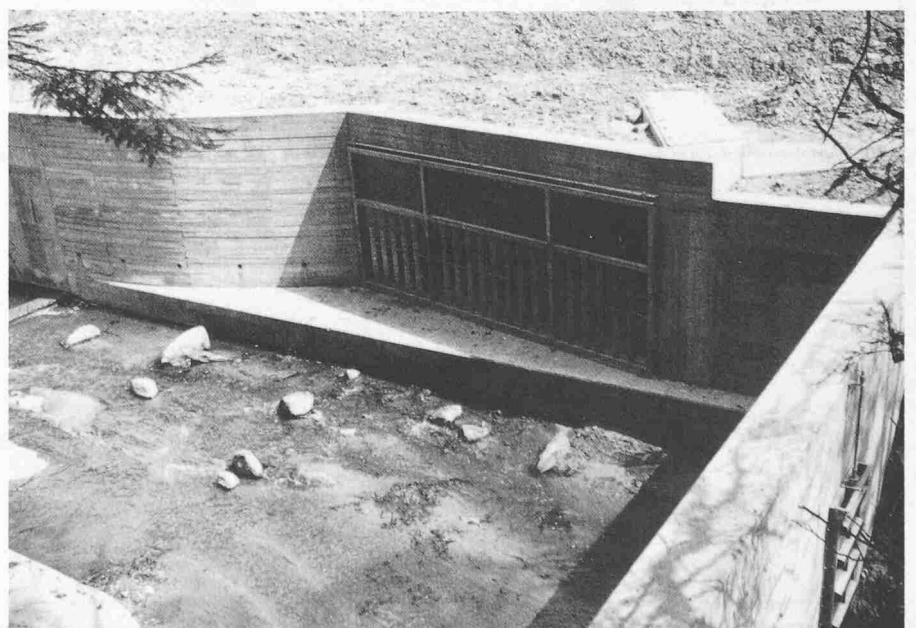
Bild 6. Einlaufbauwerk mit Überlaufschwelle und Rechen
