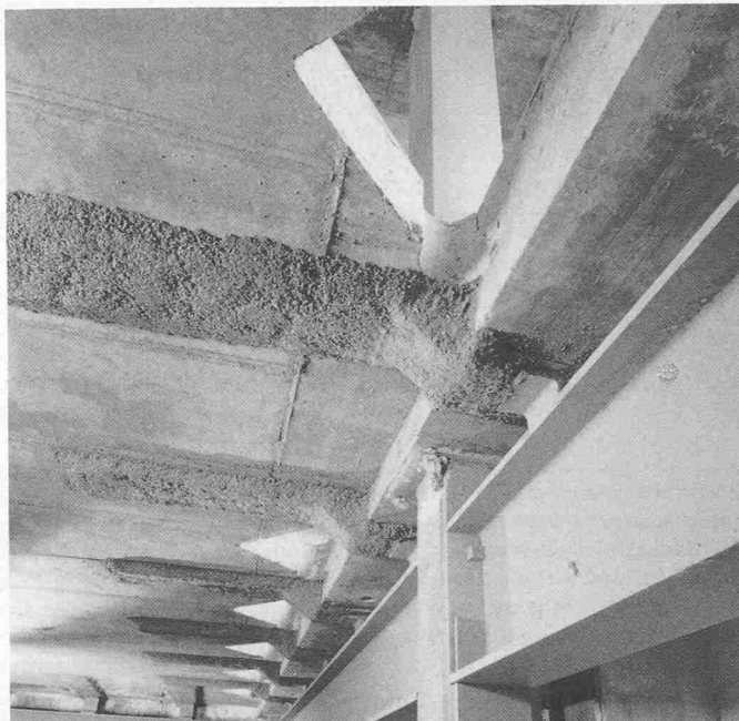
Bild 3. Gleiches Objekt wie Bild 2. Gut sichtbar sind die für die Installation der Klimaanlage benötigten Durchbrüche sowie die thermische Isolierung der geklebten Stahlprofile
