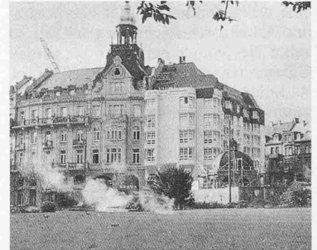
Mehr Wohnungen in der Innenstadt durch Um- und Anbau eines historischen Palasthotels, Kranplatz, Wiesbaden, 1977
