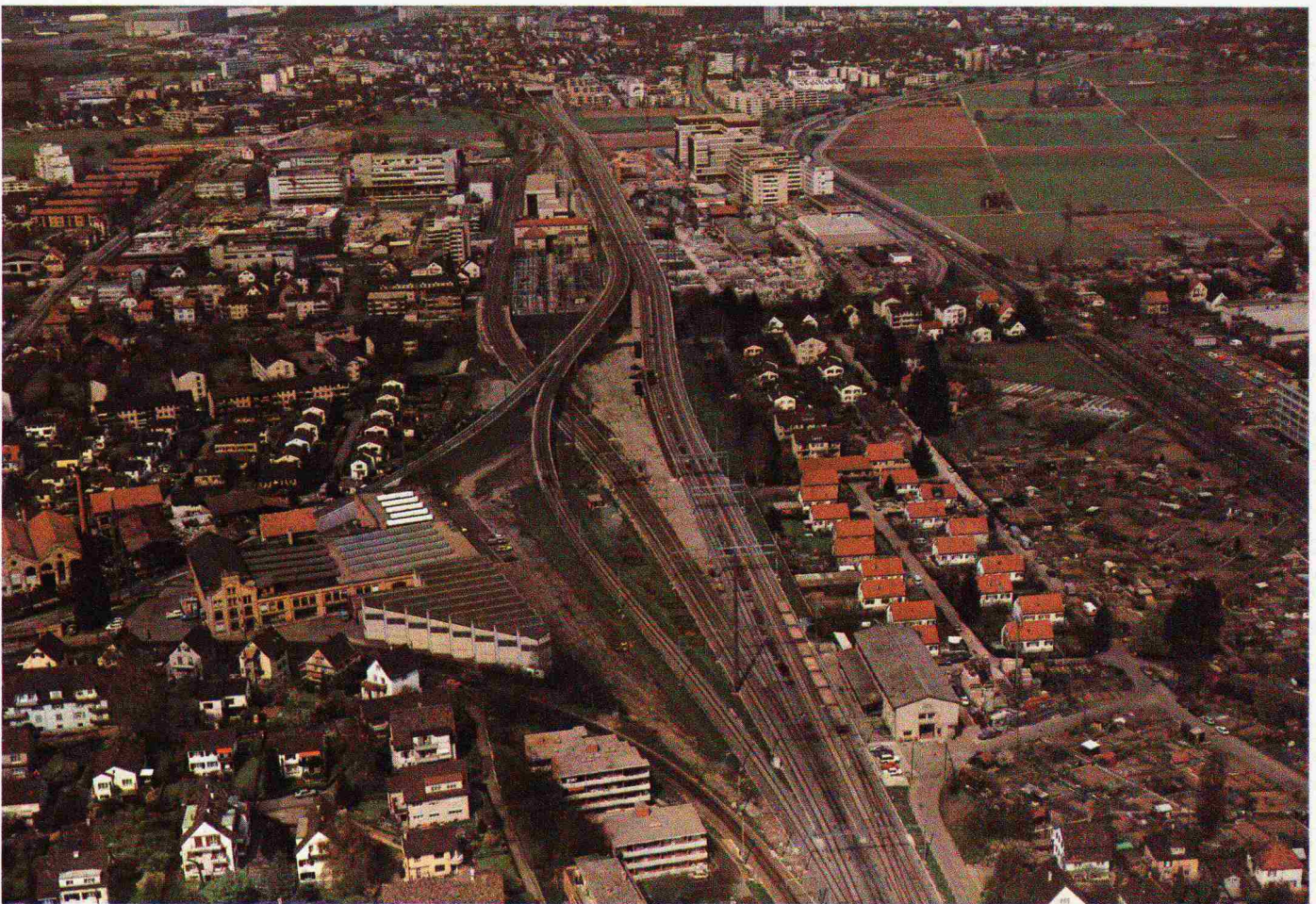
Bild 1. Brückenbauten im Oberhauserried
