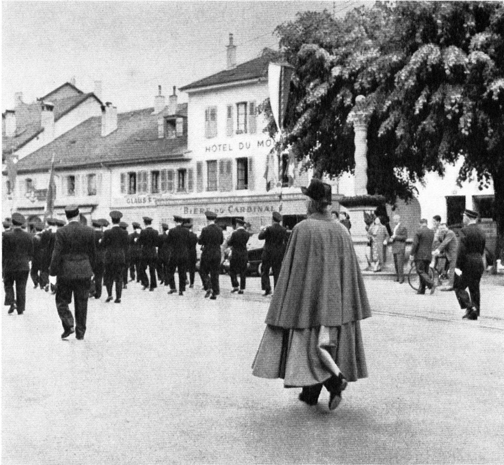
Fanfare municipale. Extrémité de la rue Ancienne, côté Rondeau. Maisons de 1778 et 1783. Fontaine de Blavignac.
