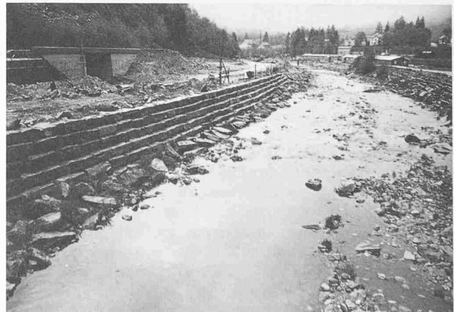
Bild 3. Aufwendige und schöne, aber schwer bepfanzbare Trockenblockmauer in Rodi-Fiesso. Hinten Trockenpflasterung, die leichter bepfanzbar ist
