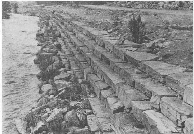
Bild 2. Aufwendige Trocken-Blockmauerung bei Rodi-Fiesso. Erschwerte Bepflanzungsmöglichkeiten durch Ausspülen des Feinmaterials aus den Fugen
