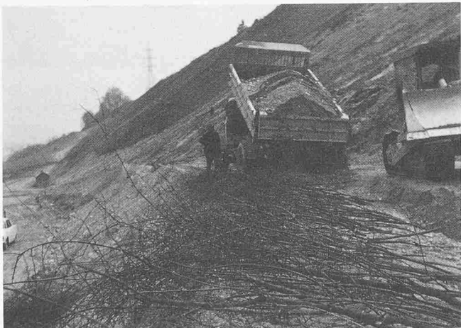
Bild 5. Buschlagenbau während der Schüttung
