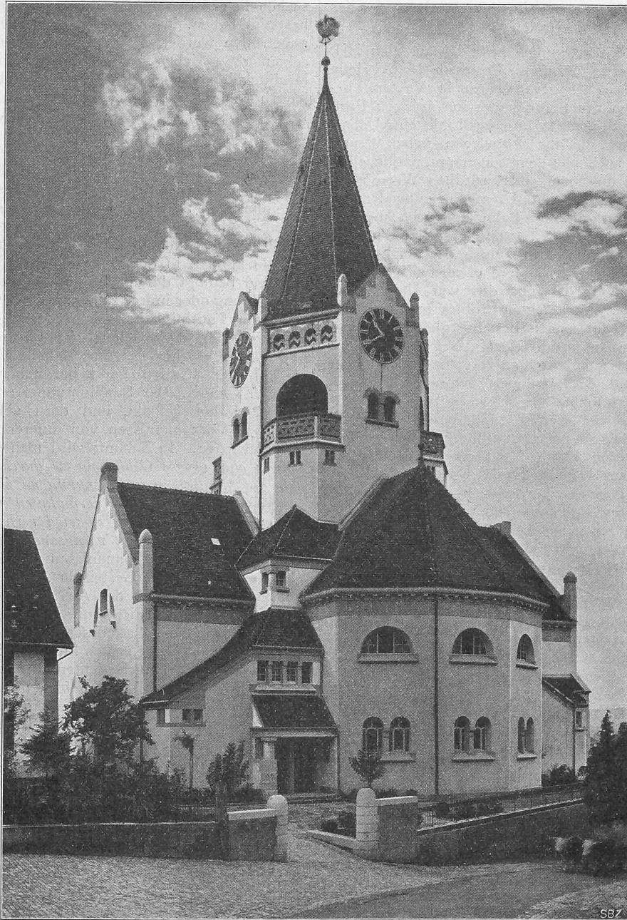
Abb. 18. Ansicht der Kirche von Nordosten.
