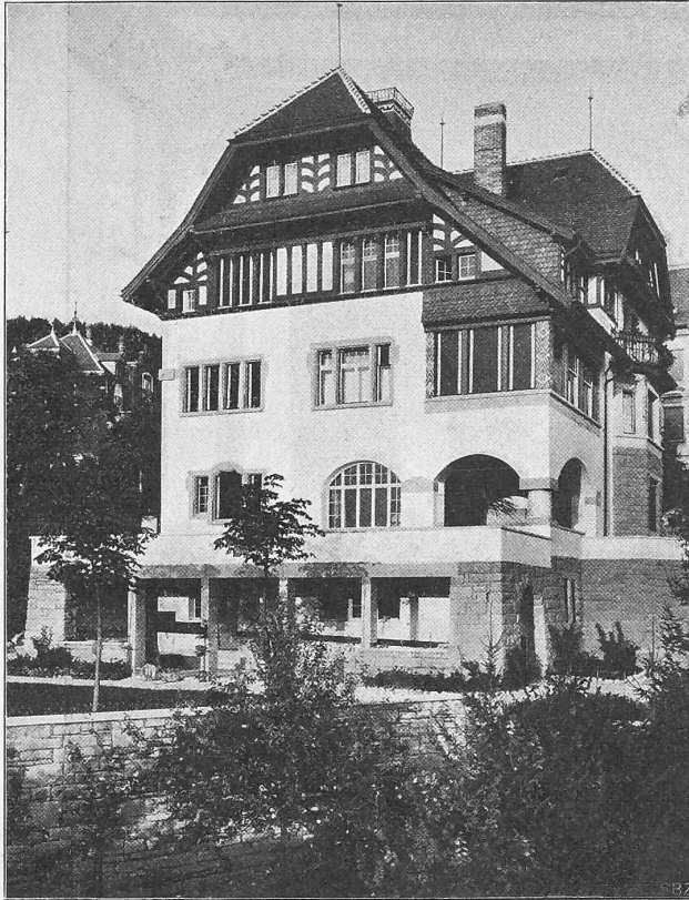
Abb. 14. Die Villa «Hadlaub» an der Rigistrasse in Zürich IV. Erbaut von den Architekten Pfleghard & Haefeli in Zürich.
