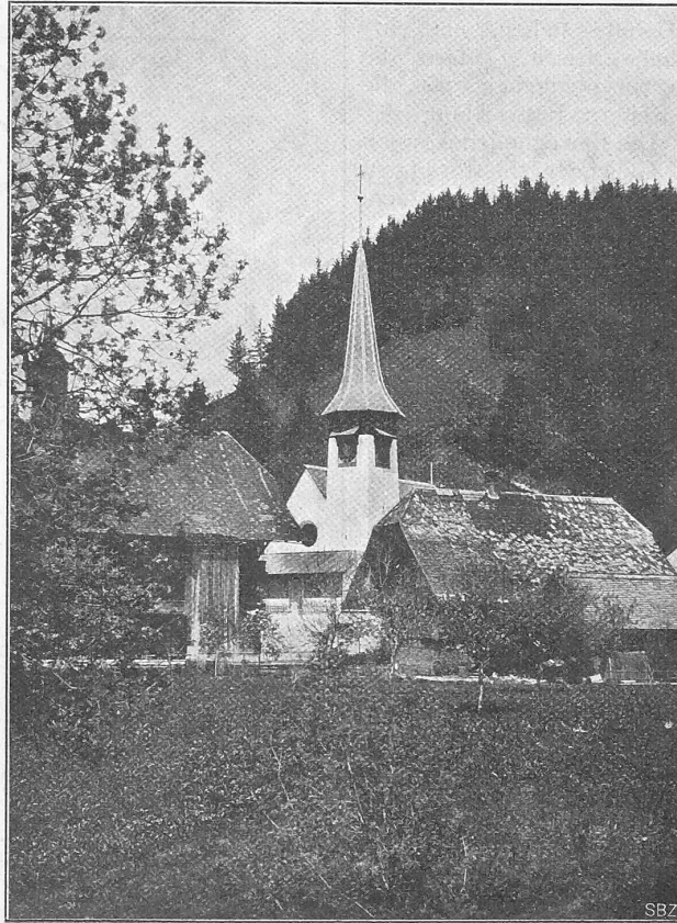
Abb. 7. Ansicht von Süd-Osten.
