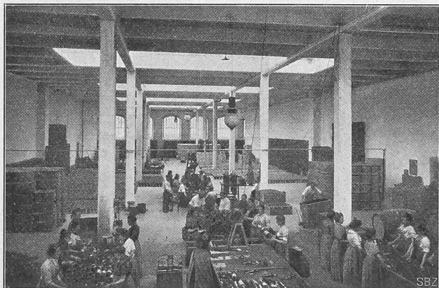
Fig. 8. Vue intérieure de l'un des trois ateliers.
